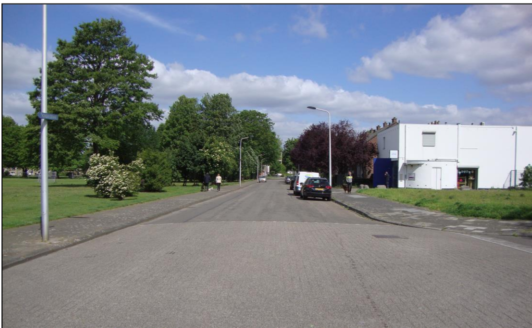
De Rondostraat in noordelijke richting
